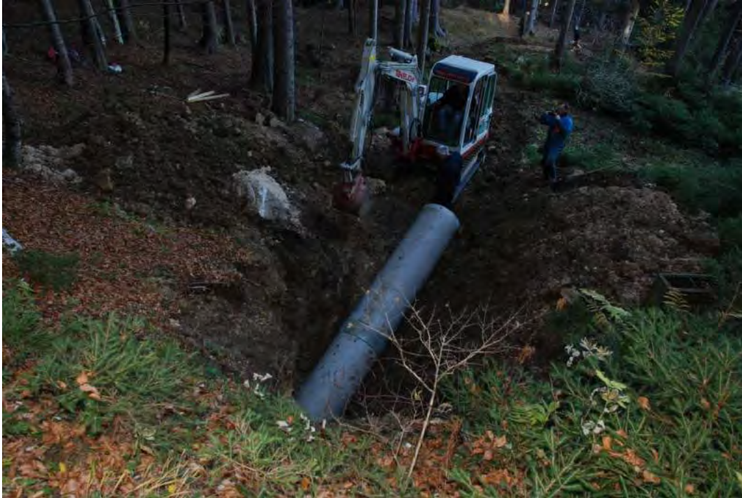
Rohrverlegung Franzisci Oberläuf 7.11.2015, Foto: Andreas LANGER
