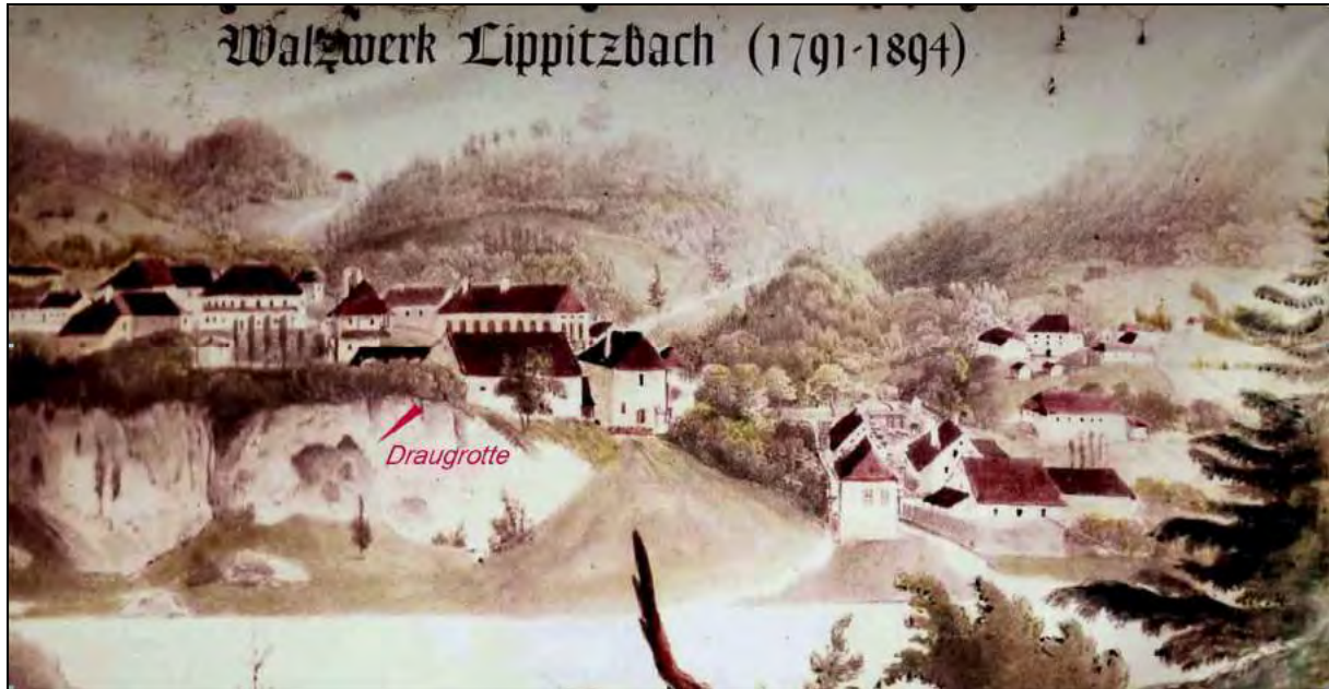
Alter Kupferstich vom Walzwerk Lippitzbach. Vor dem Aufstau der Drau befand sich die Draugrotte noch etliche Meter oberhalb des Wasserspiegels, (siehe roter Pfeil). Die Uferhöhle ist auf diesem Bild nicht sichtbar.
