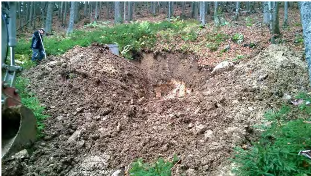
Öffnung des Stollenmundloches 29.10.2015, Foto: Harald LANGER
