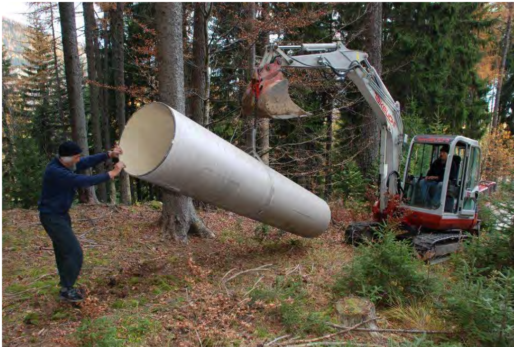
Rohrtransport zum Eingang, Foto: Andreas LANGER
